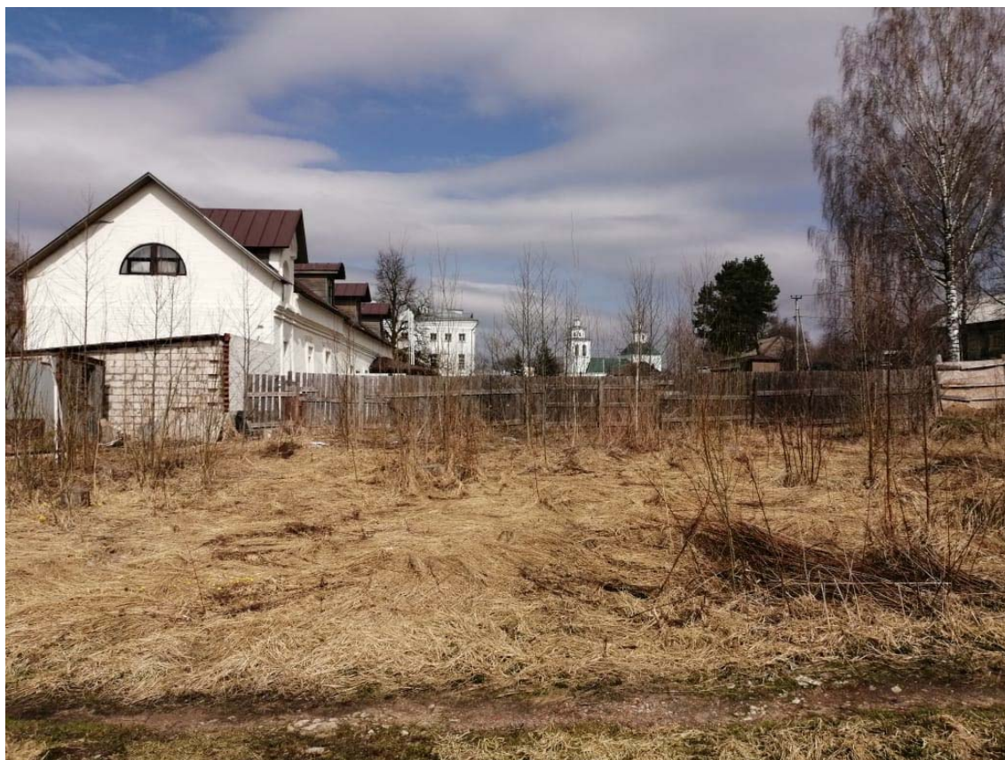
Фото.10 Вид на ткацкий корпус с южной стороны
